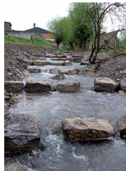
Beseitigung einer Wehranlage an der Brucht vor und nach dem Umbau
