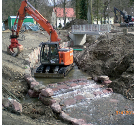
Böschungs- und Sohl Sicherungen im Bereich Theresienhof in Goslar, April 2018
