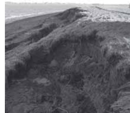
Sturmflutschäden am Flughafendeich in Nordenham-Blexen nach der Sturmflut vom 16.02.1962
