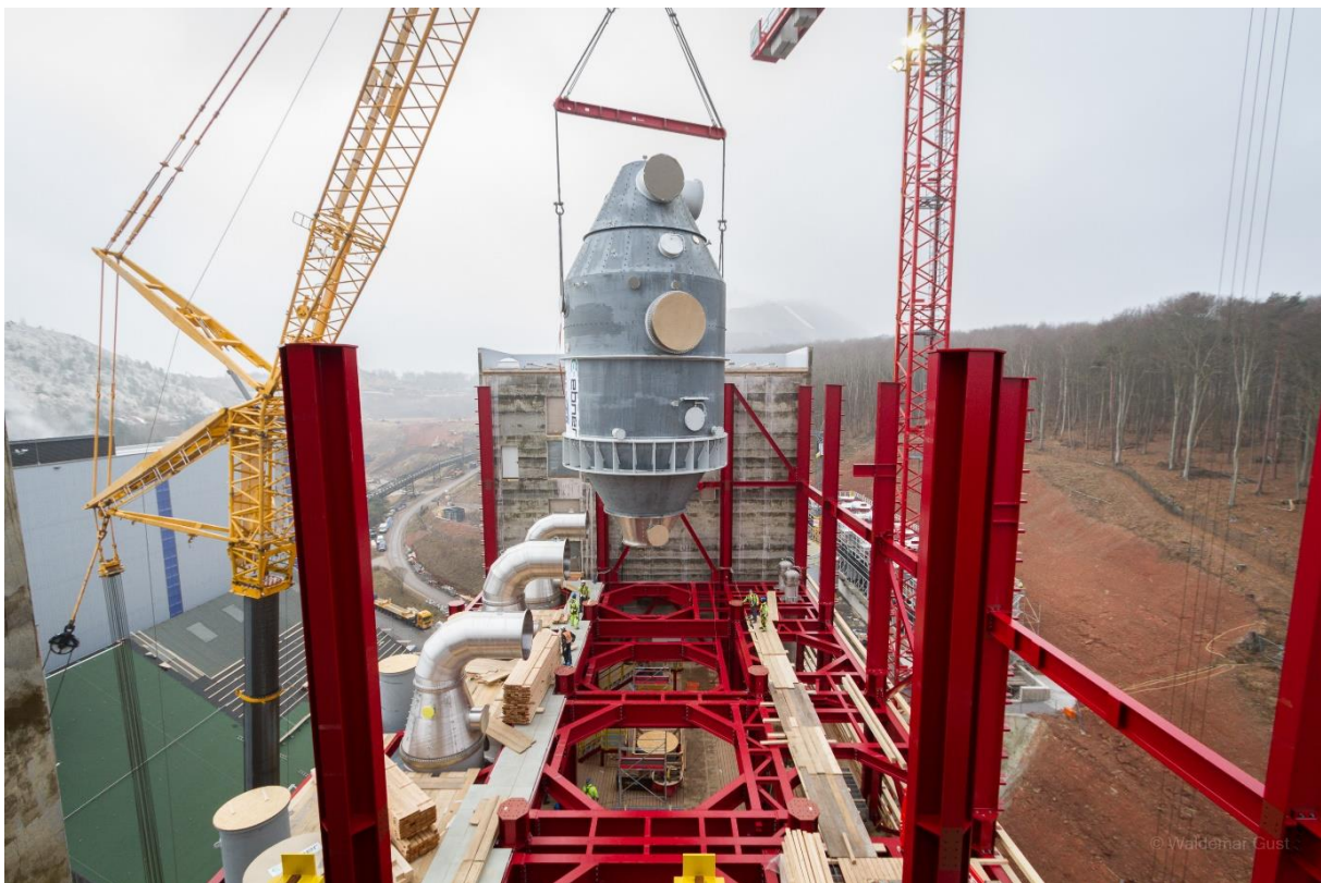
Abbildung 1: Einheben des größten Verdampfers in der KKF während der-Bauphase
