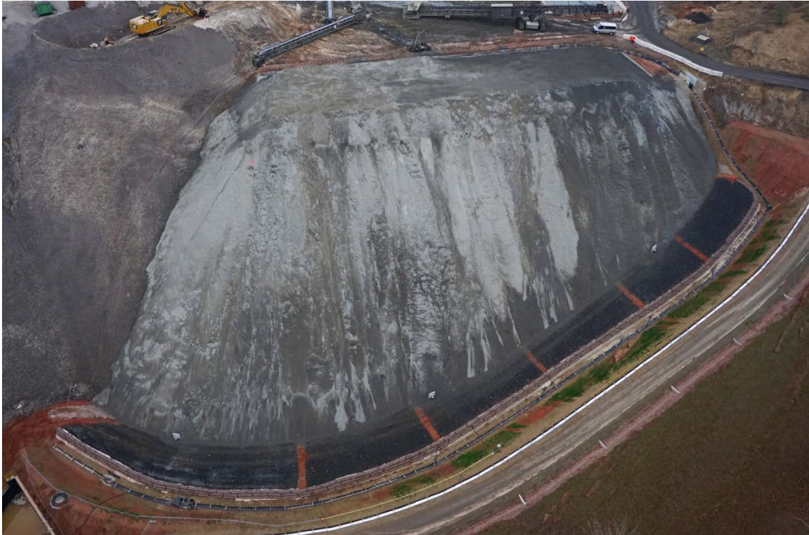
Abbildung 7: abgedeckte Flankenansicht am 30.11.2018 - Halbtechnischer Versuch Hattorf
