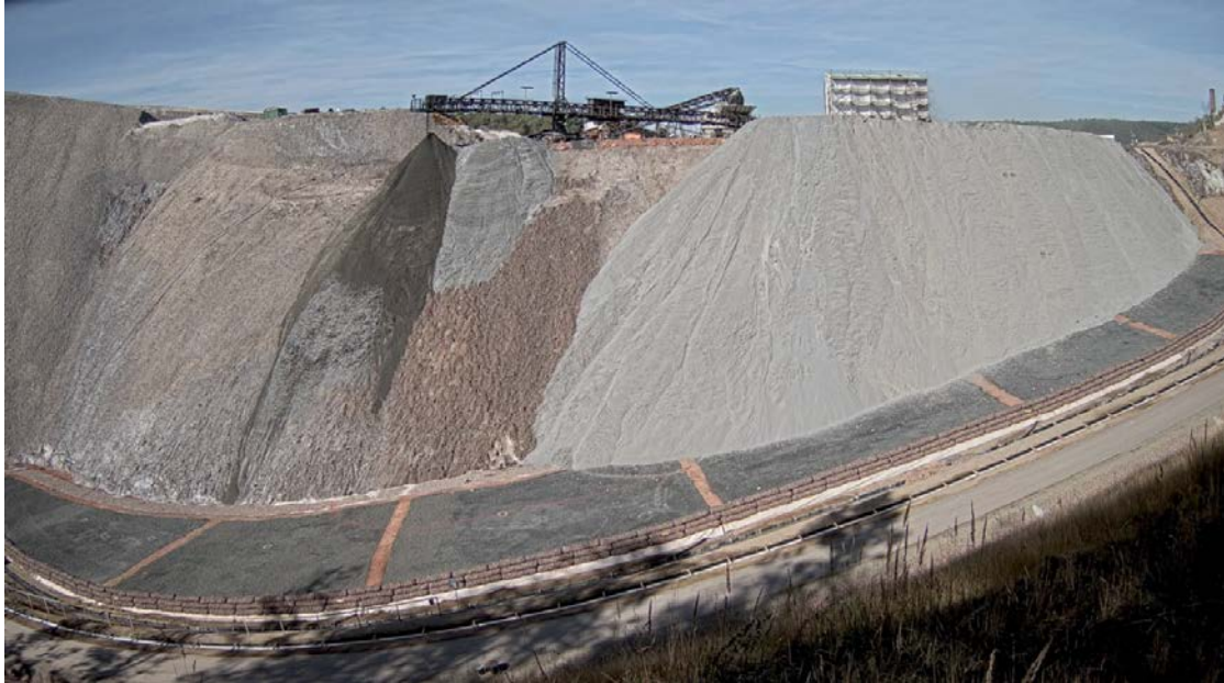
Abbildung 2: Durchführung der Flankenbeschüttung im Spätsommer/Herbst 2018 - Halbtechnischer Versuch Hattorf
