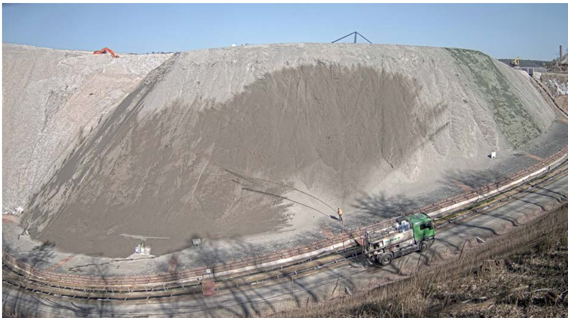
Abbildung 3: Nassansaat im Frühjahr 2019 – Halbtechnischer Versuch Hattorf
