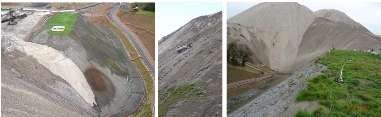
Abbildung 4: Begrünungszustand im Sommer 2019 (links) und Nachbehandlung/Nachsaat im Herbst 2019 (Mitte, rechts) – Halbtechnischer Versuch Hattorf
